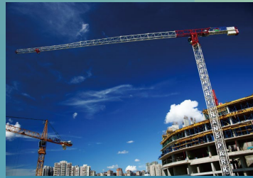
智慧工地 Smart Construction Site Management
